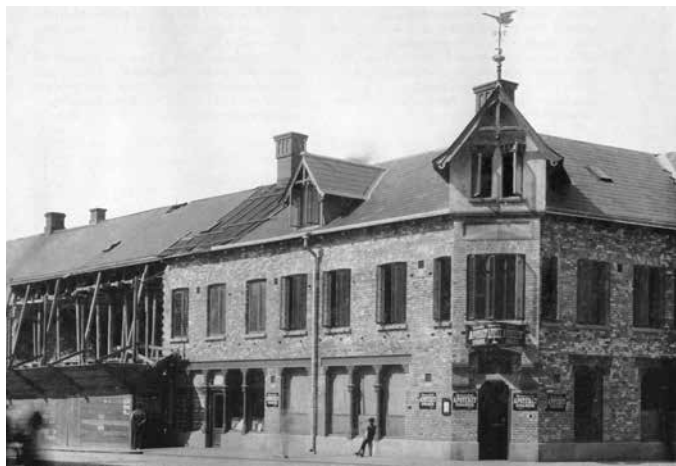
Apoteket Svanen under och efter ombyggnationen 1897 – 1899.
