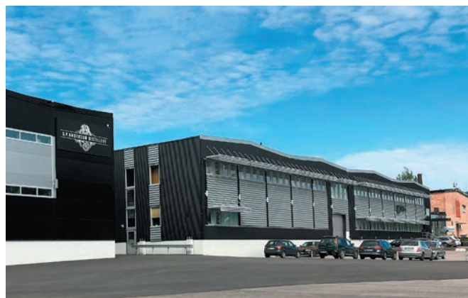
Nuvarande fabriksanläggning i Matfors med OP Andersson Distillery tv och Unimedic th. Den gamla fabriksbyggnaden i tegel längst till höger.
