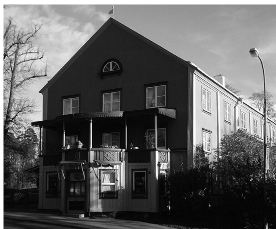
Före detta apoteket Vasen vid Gröna lund t.v. Apotekshuset vid Djurgårdsbrunn t.h.
